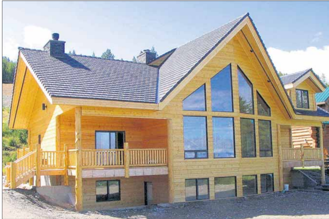
'De Gezonde Woning' kan alle vormen en maten aannemen en wordt gebouwd in hout met een kunststof dak. (Foto: Aangeleverd)
